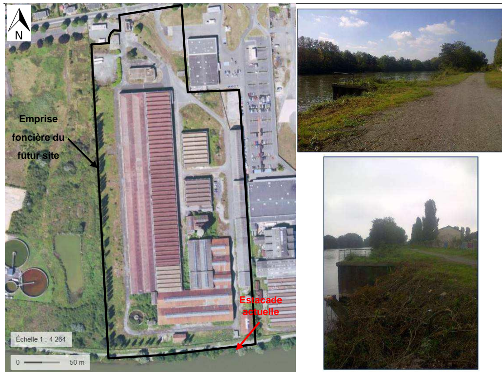
Figure 5-2 : Localisation et photographies de l'estacade actuellement présente au Sud-est du site Terbis (Source : géoportail et Terbis)
